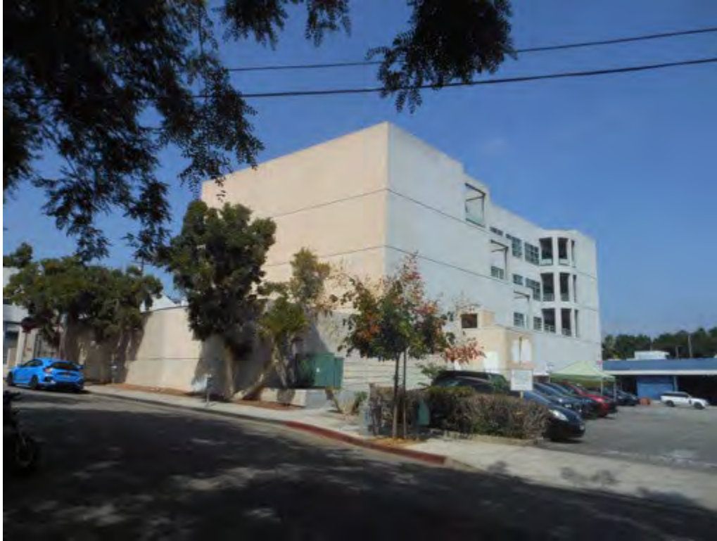
5. 825 N. San Vicente Boulevard, Hilldale Avenue elevation
