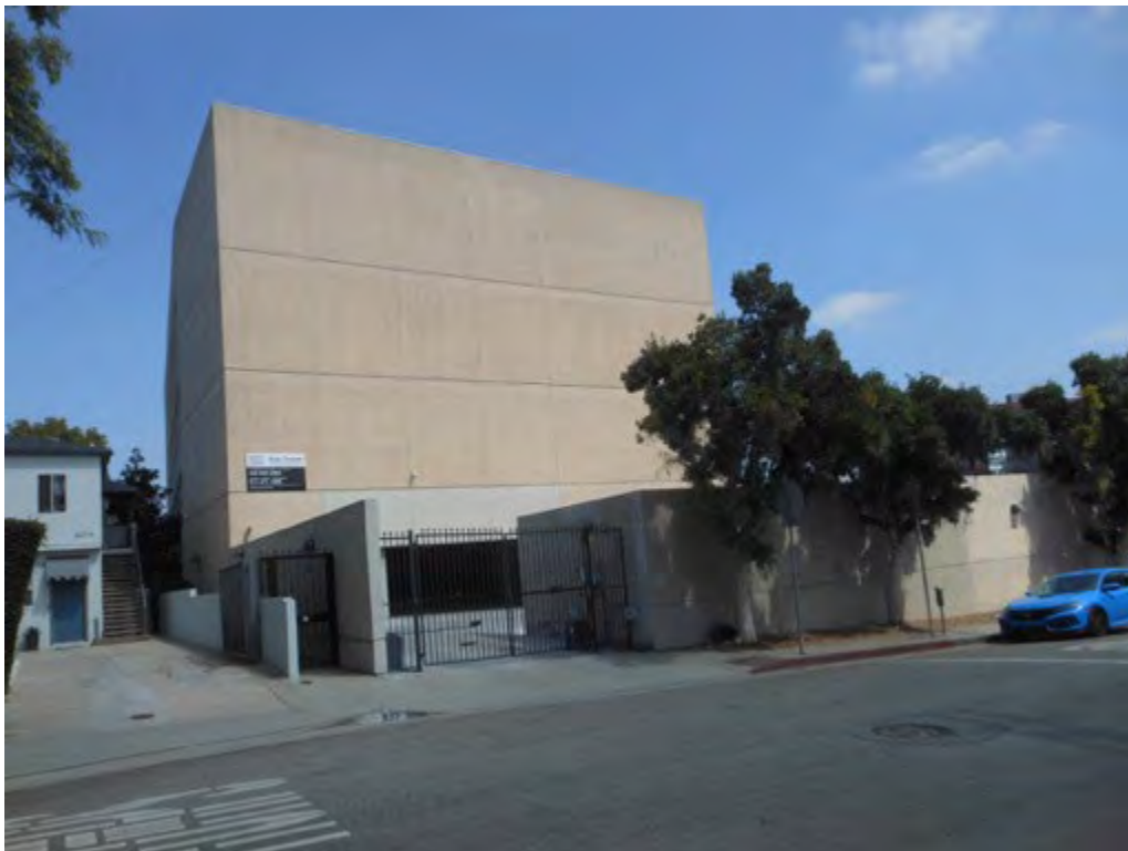
6. 825 N. San Vicente Boulevard, Hilldale Avenue elevation
